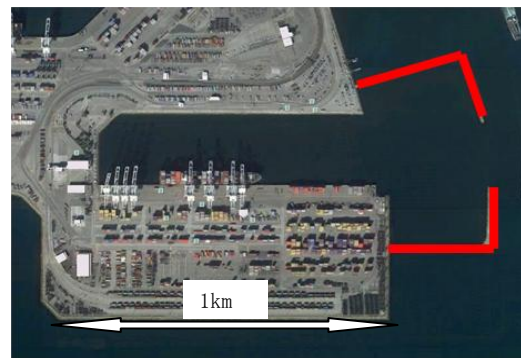
図-1 ロングビーチ港Pier Jの防波施設
